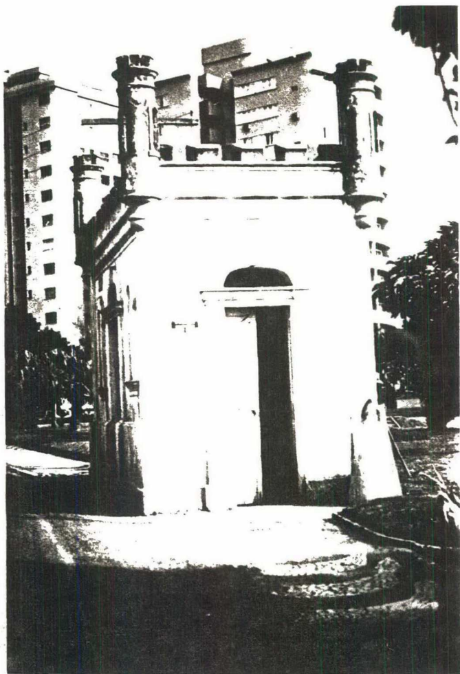
— Vista do prédio da Estação Elevatória de Esgotos da Praça Celso Ramos - Bairro Agronômica - construída em 1916.
