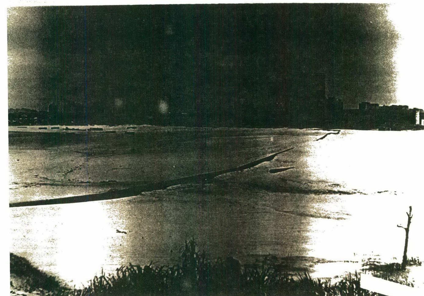
- O aterro da baía sul em execução - ano de 1970. (Foto: Anacleto).
