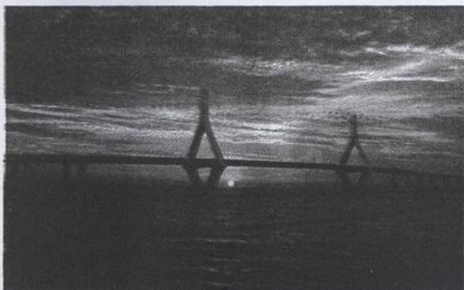
Baia Norte. Projeto da Engevix/Paulitec é a ponte estaiada com quatro pistas em cada sentido
