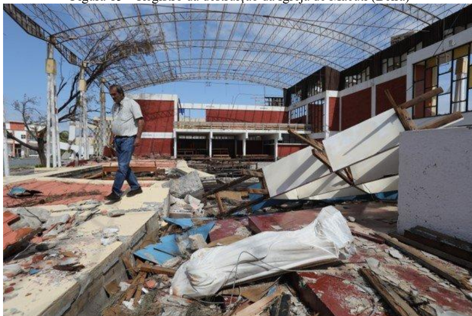
Figura 15 – Registro da destruição da Igreja de Macuti (Beira)
