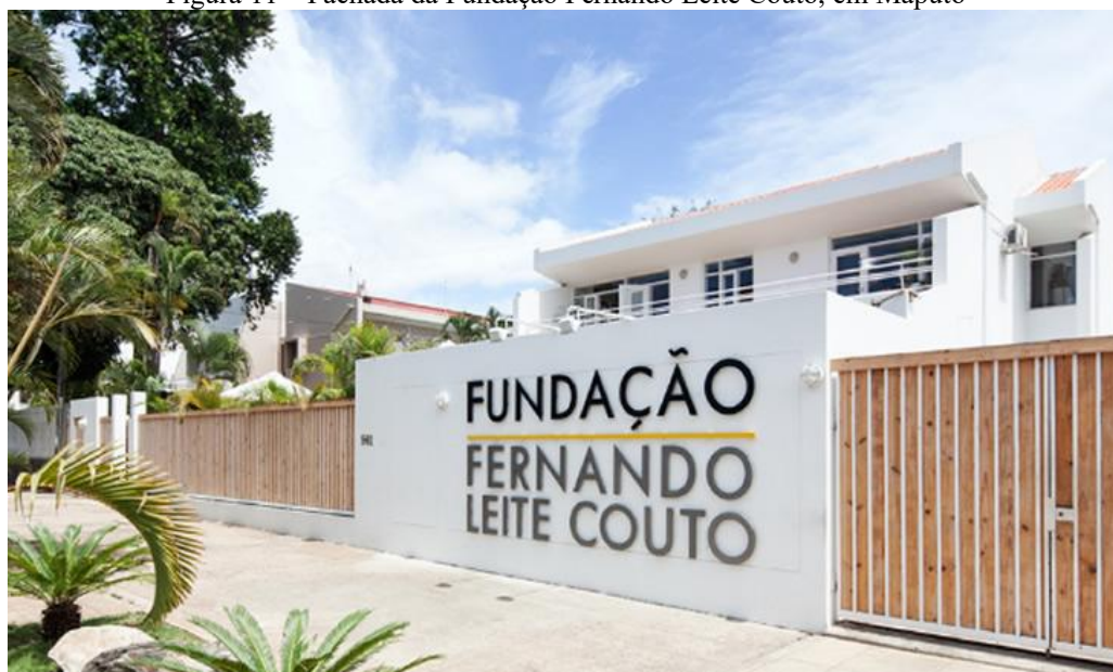
Figura 11 – Fachada da Fundação Fernando Leite Couto, em Maputo
