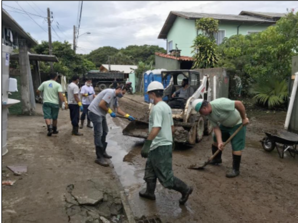
Figura 2 – Realização da limpeza realizada na Servidão após o rompimento da lagoa de evapoinfiltração
