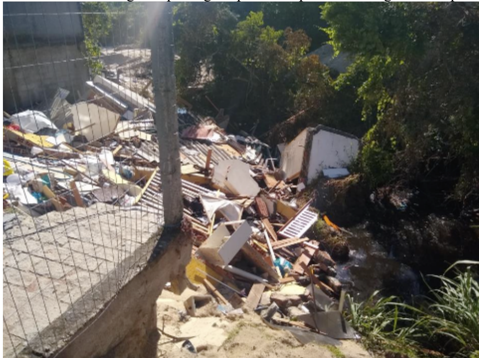
Figura 3 – Escombros carregados pela água após o rompimento da lagoa de evapoinfiltração
