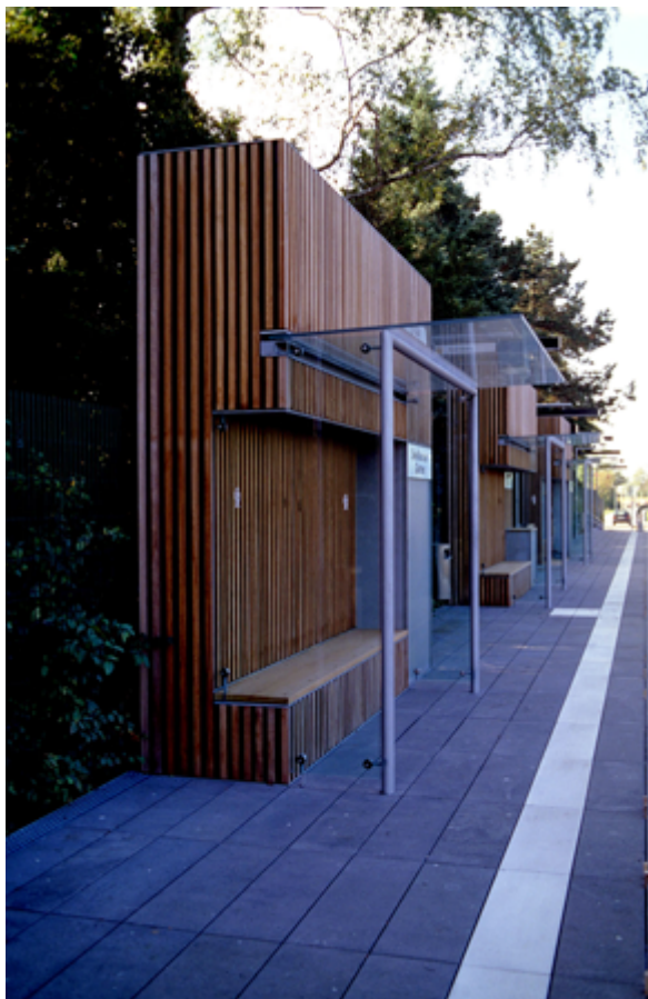
Figura 13 - Abrigo de Estação de trem urbano em Hannover, Alemanha.
