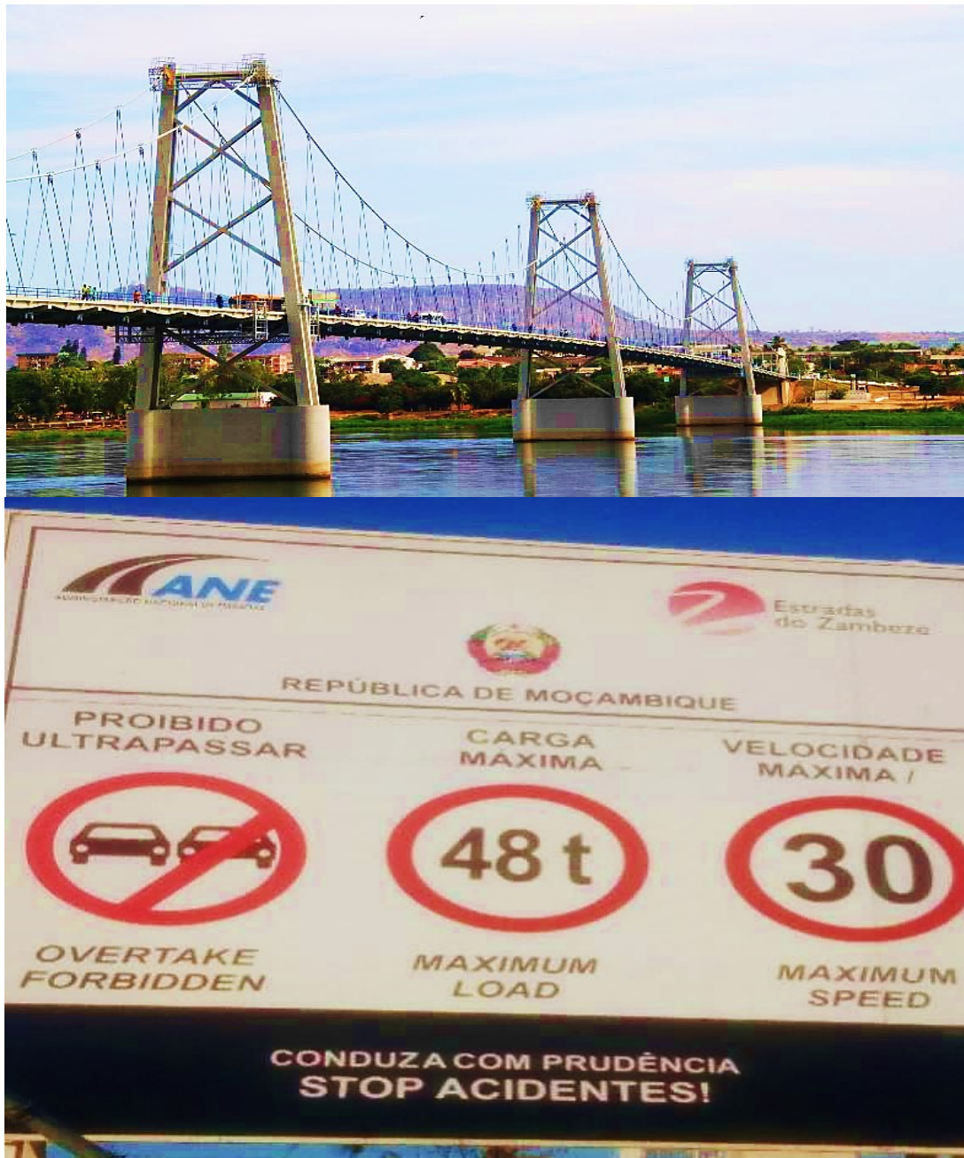
Fig. 17: Reabilitação da ponte Samora Machel sobre o rio Zambeze cidade de Tete-Moçambique
