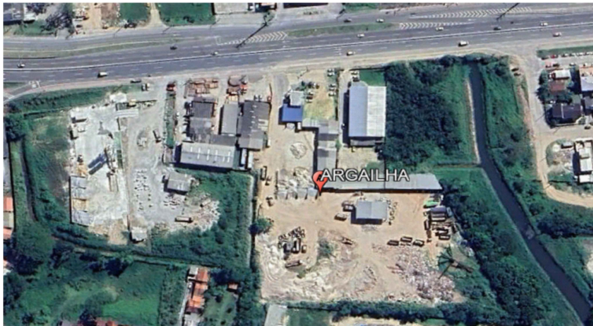
ARGALHA - Rod. Armando Calil Bulos, 2.612 - Ingleses / Florianópolis DMT (OBRA → BOTA-FORA) = 35,4 Km
