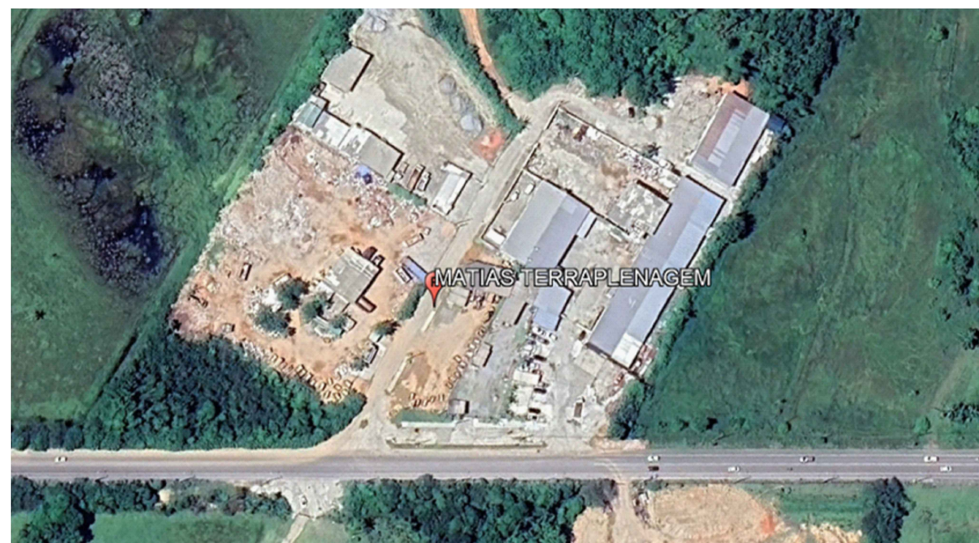
MATIAS TERRAPLENAGEM - Rod. Aparício Ramos Cordeiro, 2.751 - Campeche / Florianópolis DMT (JAZIDA → OBRA) = 2,8 Km
