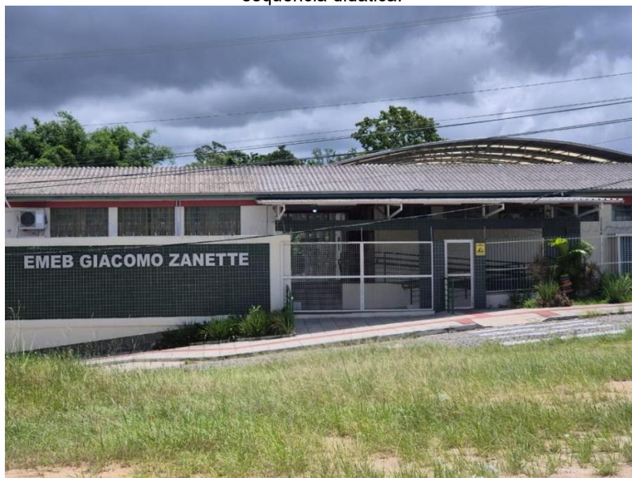
Figura 3 - Fachada da Escola Municipal de Educação Básica Giácomo Zanette, local de aplicação da sequência didática.
