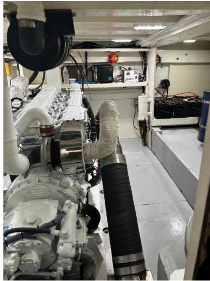
Figura 31 – Sala de máquinas reformada da escuna
