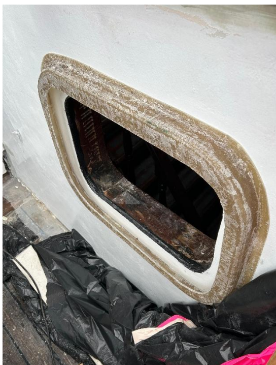
Figura 28 – Esquadria da janela refeita com fibra de vidro
