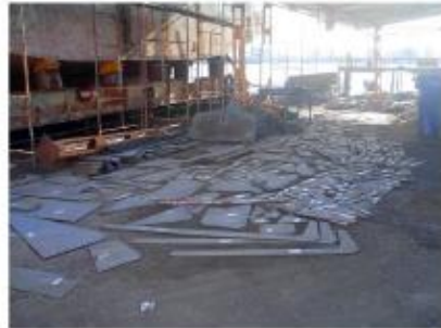
Peças das estruturas
