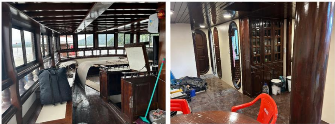
Figura 30 – Área interna do convés em modificação
