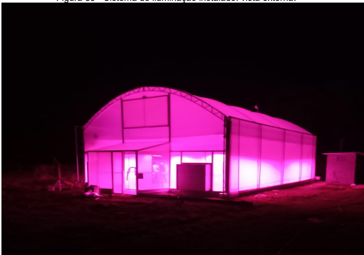
Figura 39 - Sistema de iluminação instalado: vista externa.
