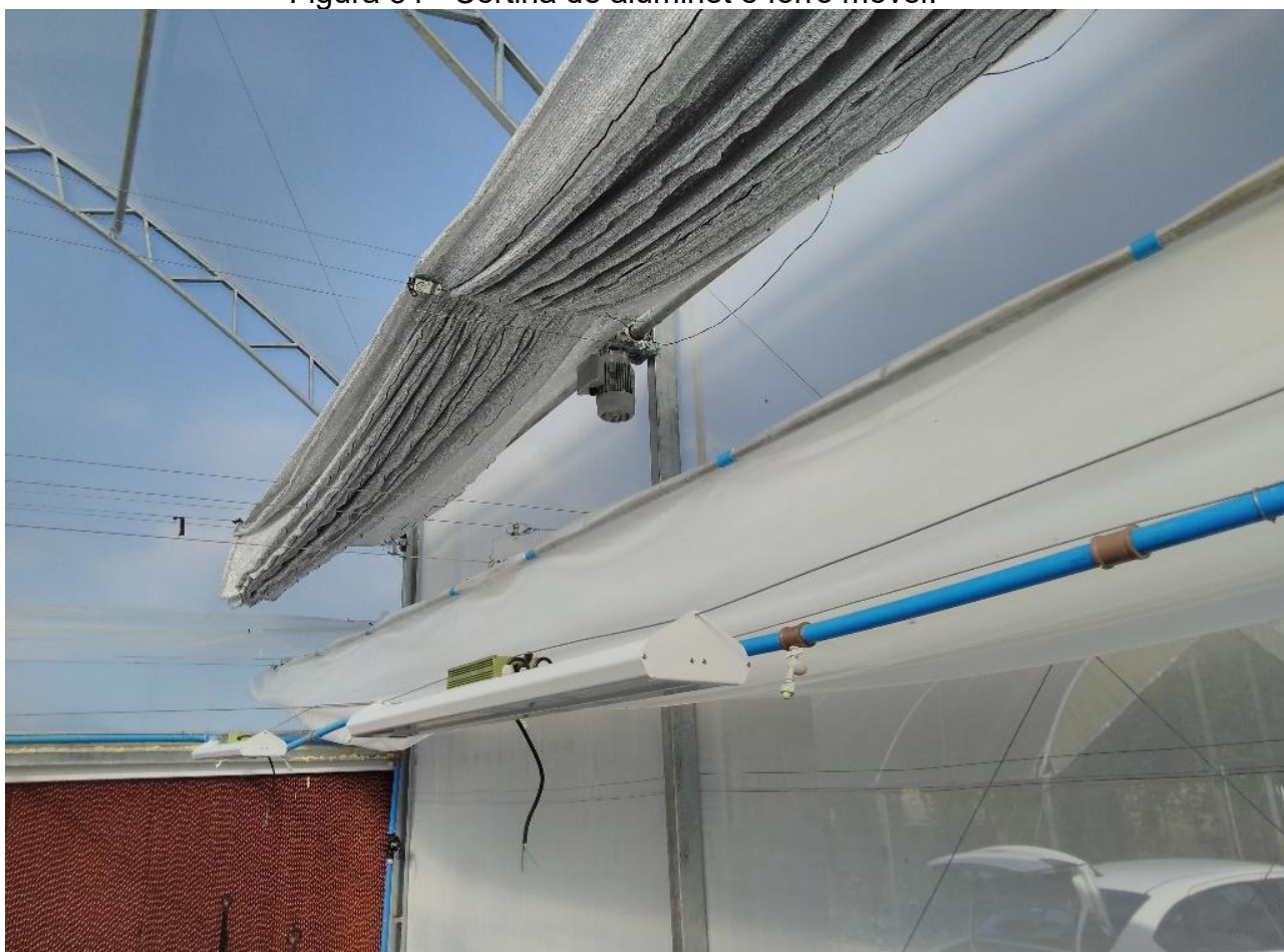
Figura 34 - Cortina de aluminet e forro móvel.
