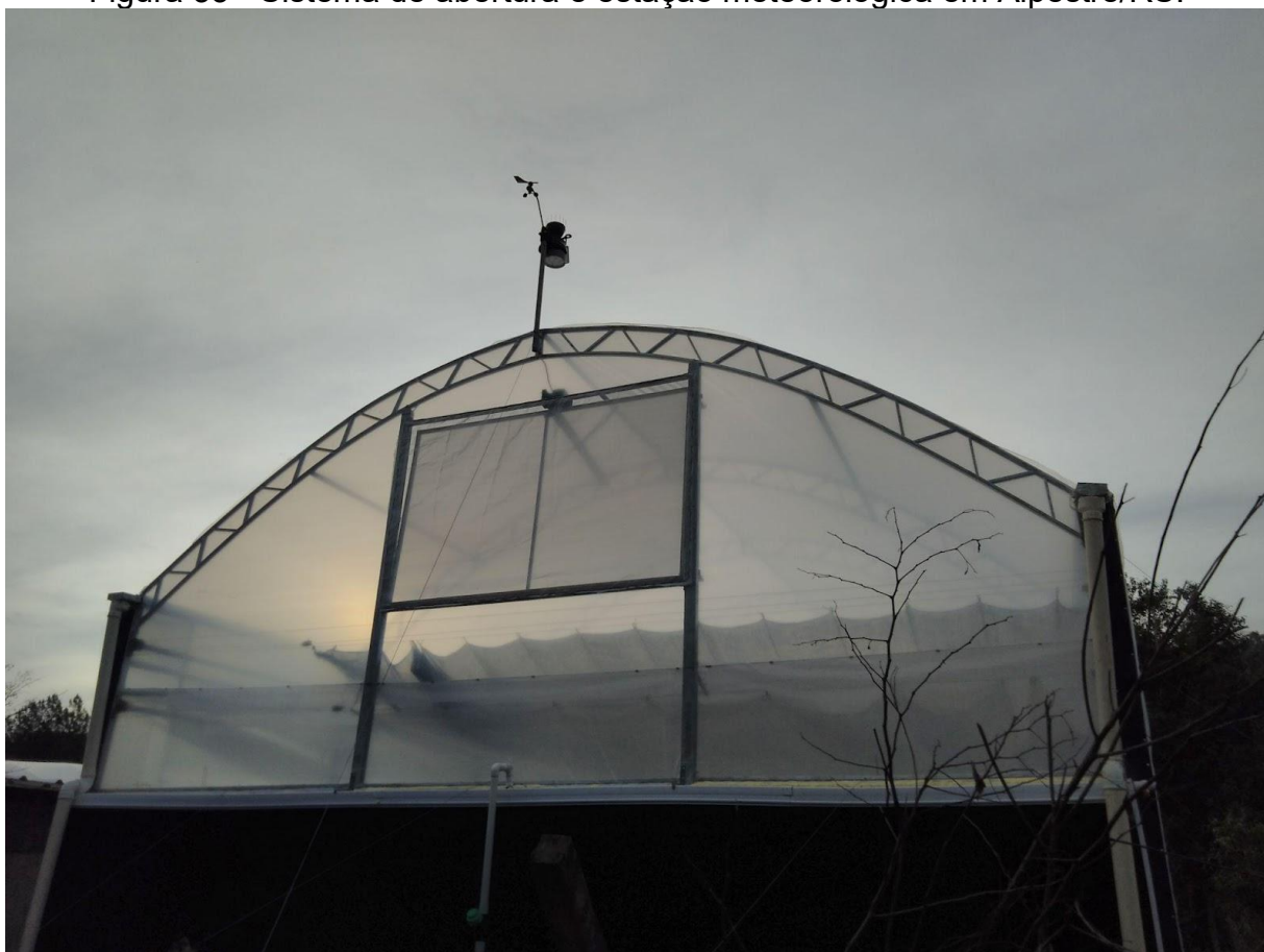
Figura 33 - Sistema de abertura e estação meteorológica em Alpestre/RS.
