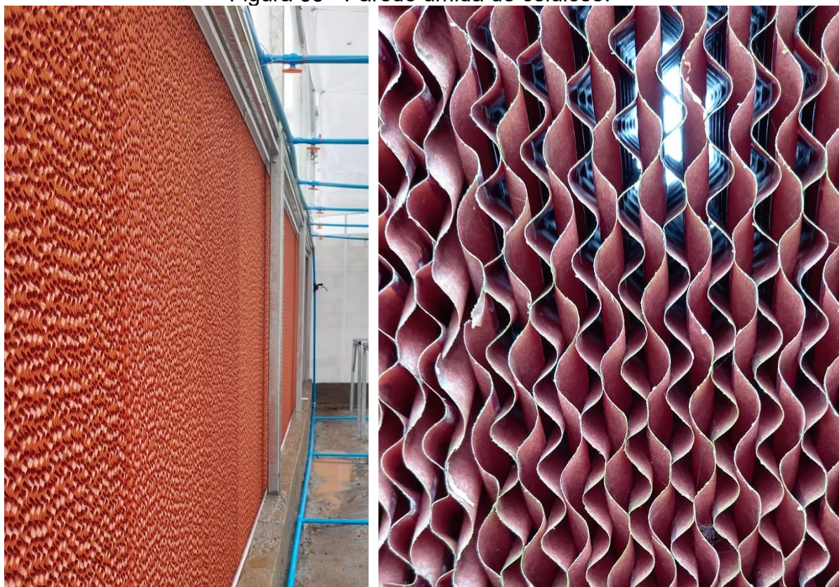
Figura 35 - Parede úmida de celulose.
