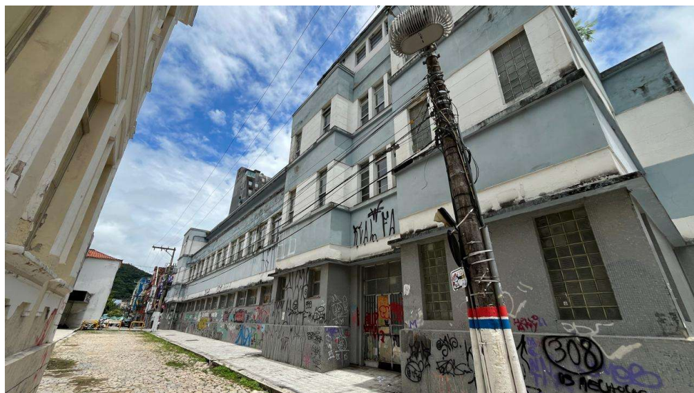
Figura 14: Edifício ocioso dos Correios no Largo Victor Meirelles.
