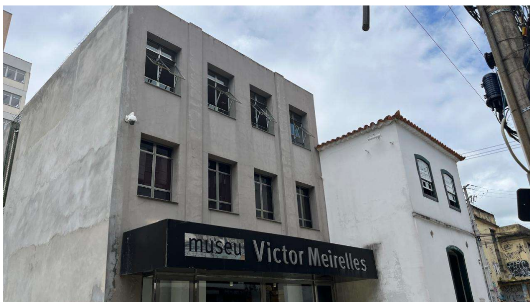
Figura 11: Fachada da Casa Natal de Victor Meirelles e edifício anexado durante as obras de 2016
