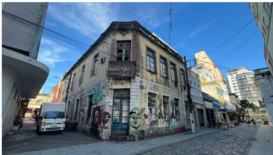
Figura 19: atual situação do edifício localizado na Travessa Ratcliff, n° 56.
