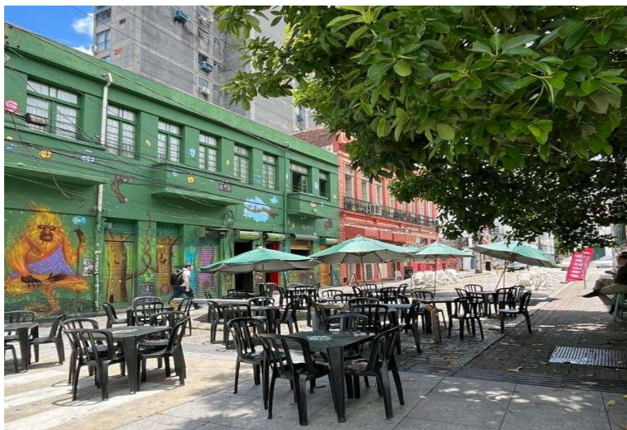
Figura 21: Estado atual do edifício onde está instalado o Bigio Bar.
