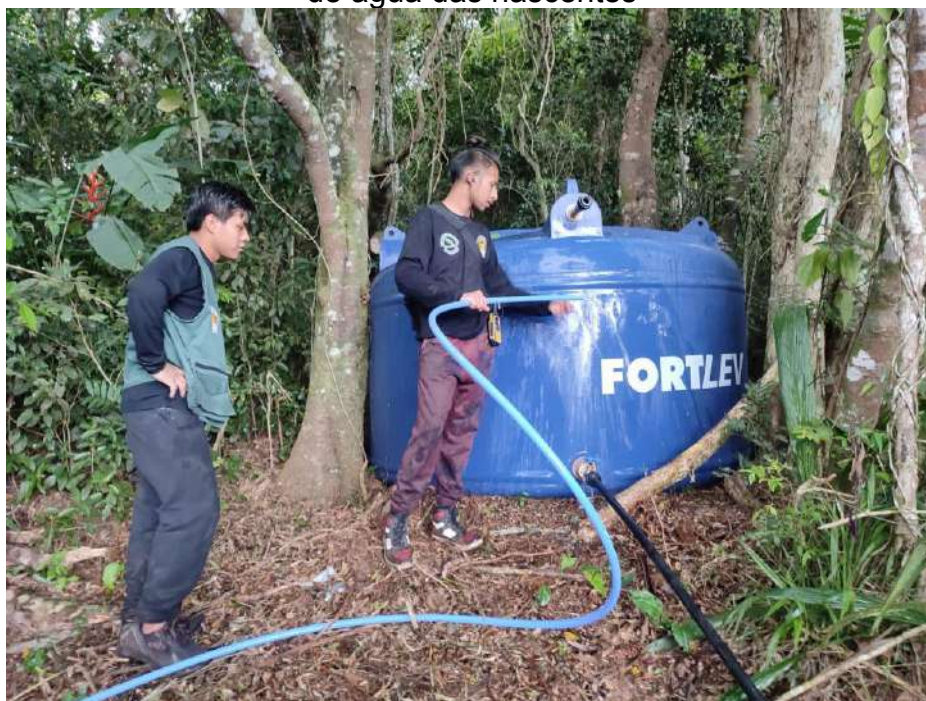
Figura 17: Monitores ambientais instalando mangueira para captação e distribuição de água das nascentes
