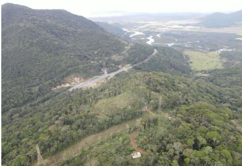
Figura 13: Rodovia BR 101 e antenas das linhas de transmissão em perspectiva
