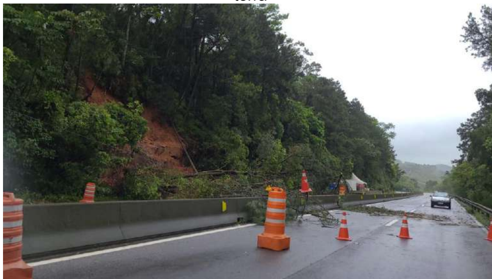
Figura 20: Rodovia BR 101 bloqueada em ambos os sentidos após deslizamentos de terra
