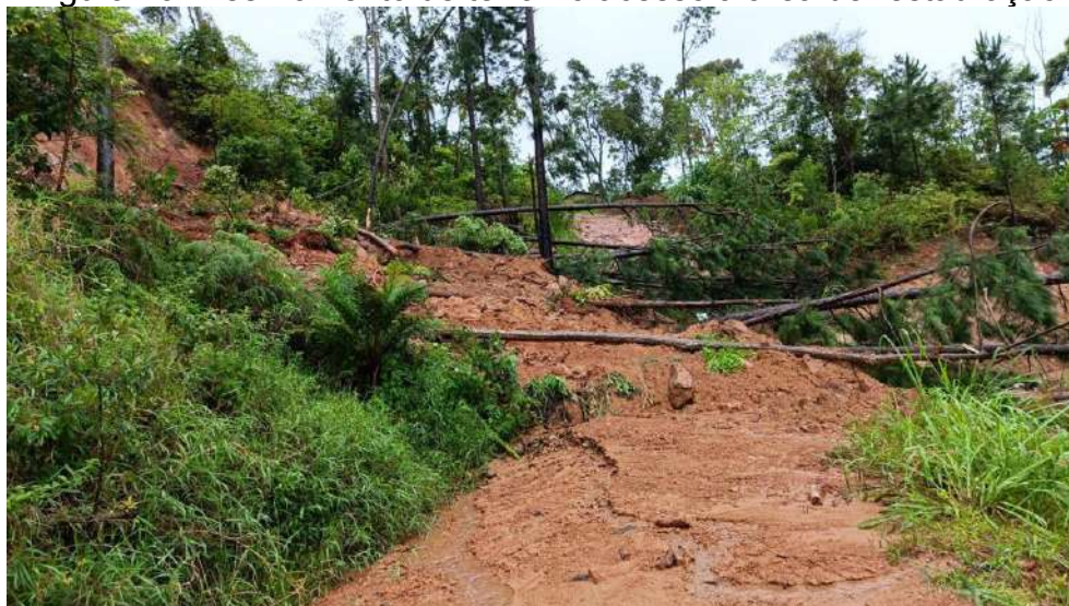
Figura 19: Deslizamento de terra no acesso à área de restauração
