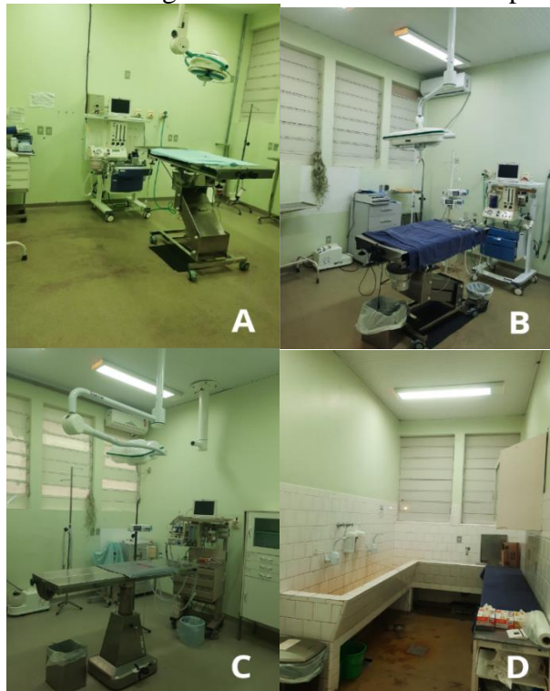
Figura 8: 8A, 8B e 8C. Salas cirúrgicas do bloco 2. 8D Área de paramentação e lavatório.
