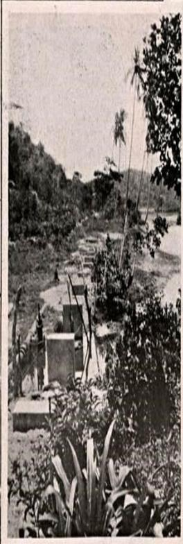
Obras do serviço de saneamento. Filares para linhas adductoras. A' esquerda, a linha adductora já existente.
