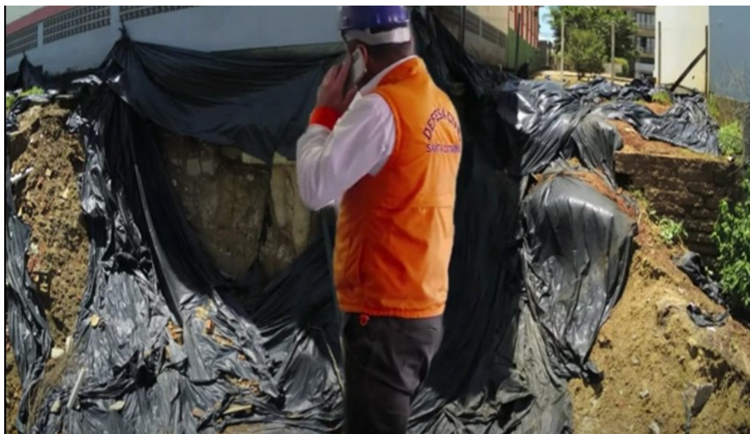
Figura 58 - Área de Risco
