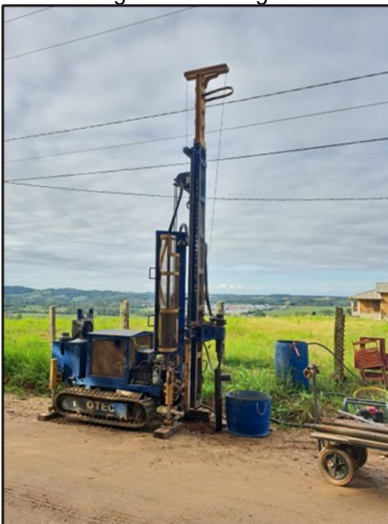
Figura 21 – Imagem da sondagem em execução
