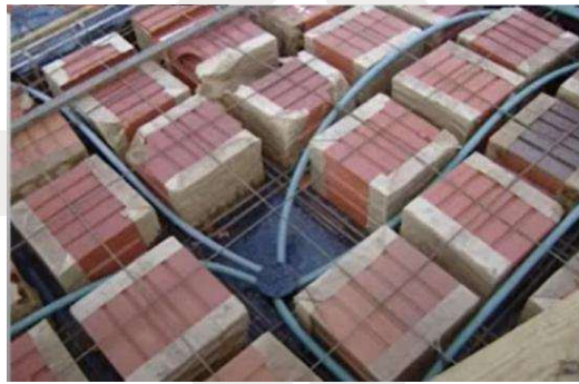
Figura 13 - Laje nervurada com preenchimento em tijolos
