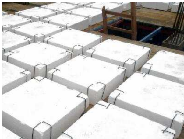
Figura 10 - Laje Nervurada em EPS vista de cima
