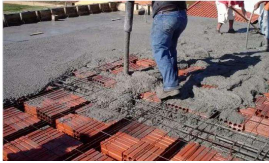
Figura 12 - Execução de laje nervurada com preenchimento em tijolos
