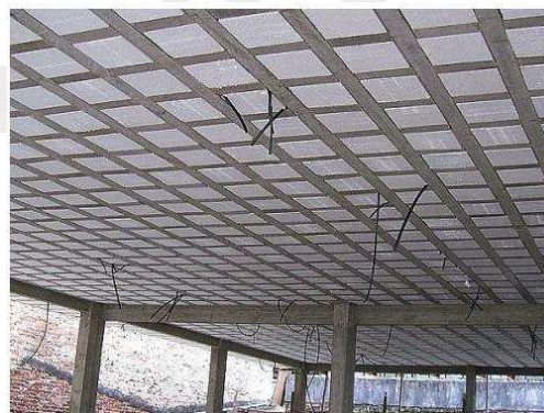
Figura 9 - Laje Nervurada em EPS vista de baixo
