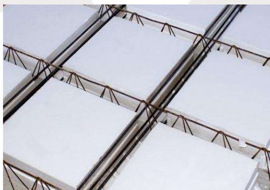
Figura 27 - Laje nervurada bidirecional em EPS
