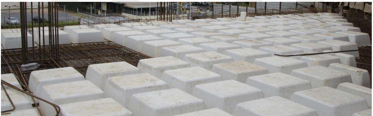
Figura 16 - Execução de laje nervurada com cubetas vista de cima
