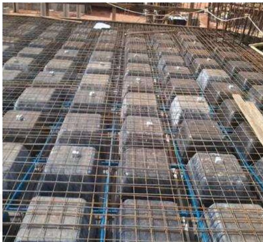
Figura 39 - Arranjo das cordoalhas em laje protendida nervurada
