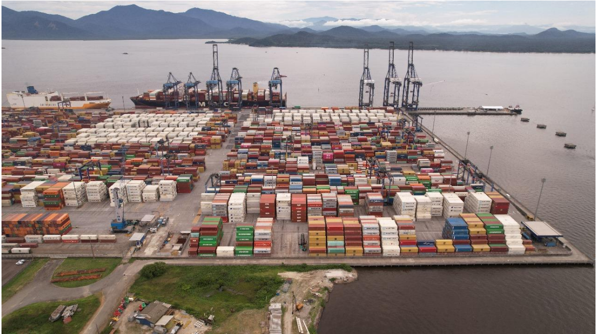
Figura 5 - Via de Acesso Alfandegada e Cais de Atracação para Cargas Rolantes.
