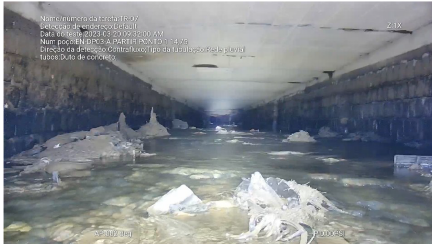
Figura 12 – Trecho da galeria do Rio Mathias na rua 9 de Março
