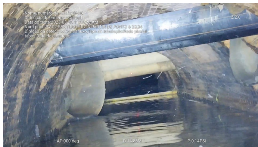
Figura 13 – Trecho da galeria do Rio Mathias na rua Visconde de Taunay
