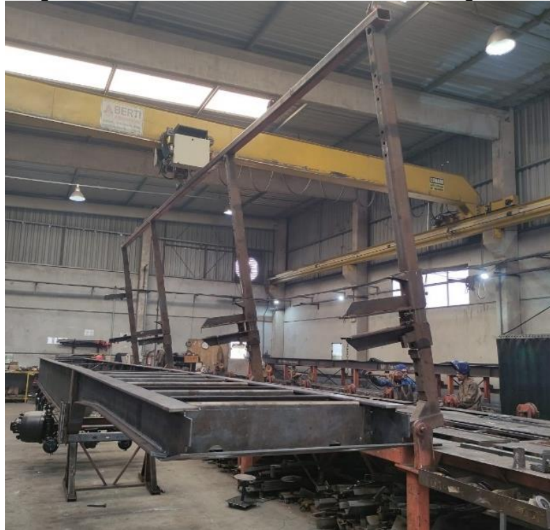
Figura 22 - Base montada sendo retirada do gabarito
