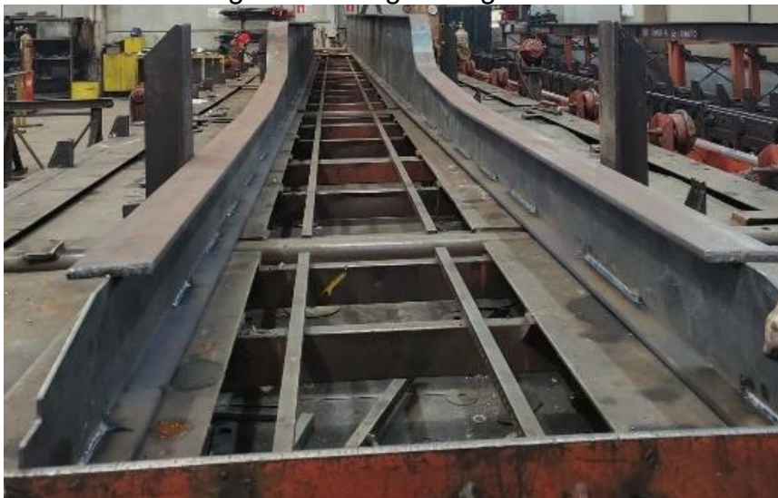
Figura 19 – Vigas no gabarito
