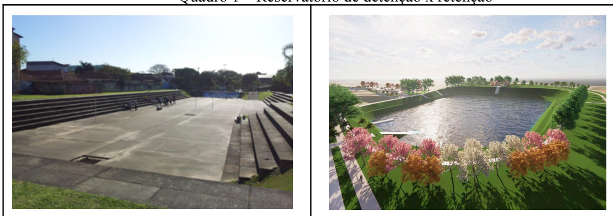
Quadro 1 – Reservatório de detenção x retenção
