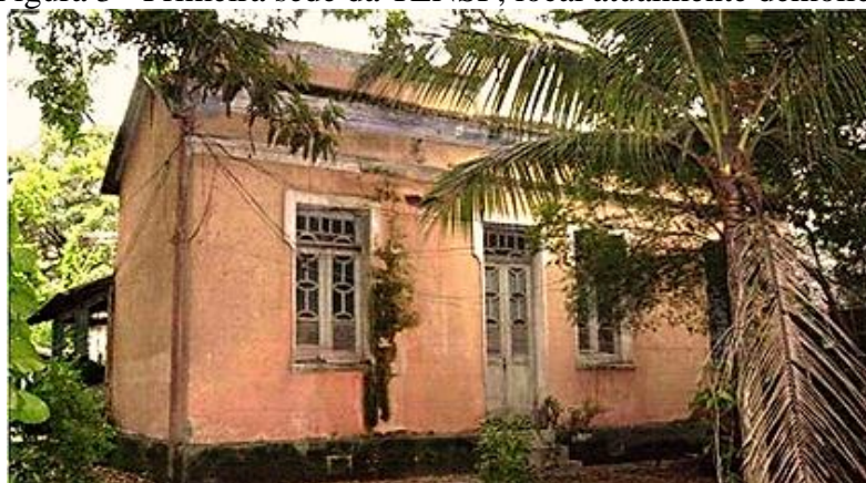
Figura 3 - Primeira sede da TENSPP, local atualmente demolido
