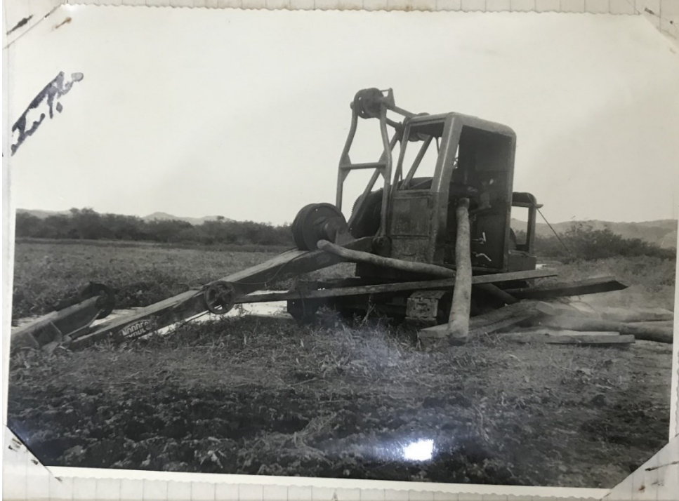
Figura 11: Vista da draga. Observa-se troncos dentro e na base do maquinário, sido colocados como alavancas pelos posseiros a fins de quebrar as peças. (1963)
