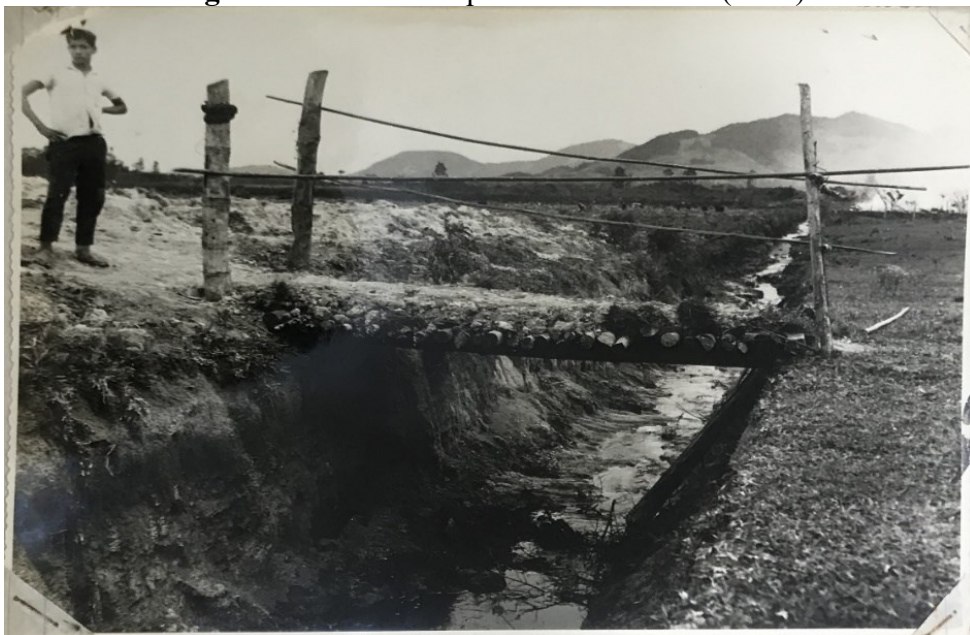
Figura 12: Pontilhão que atravessa a vala (1963)
