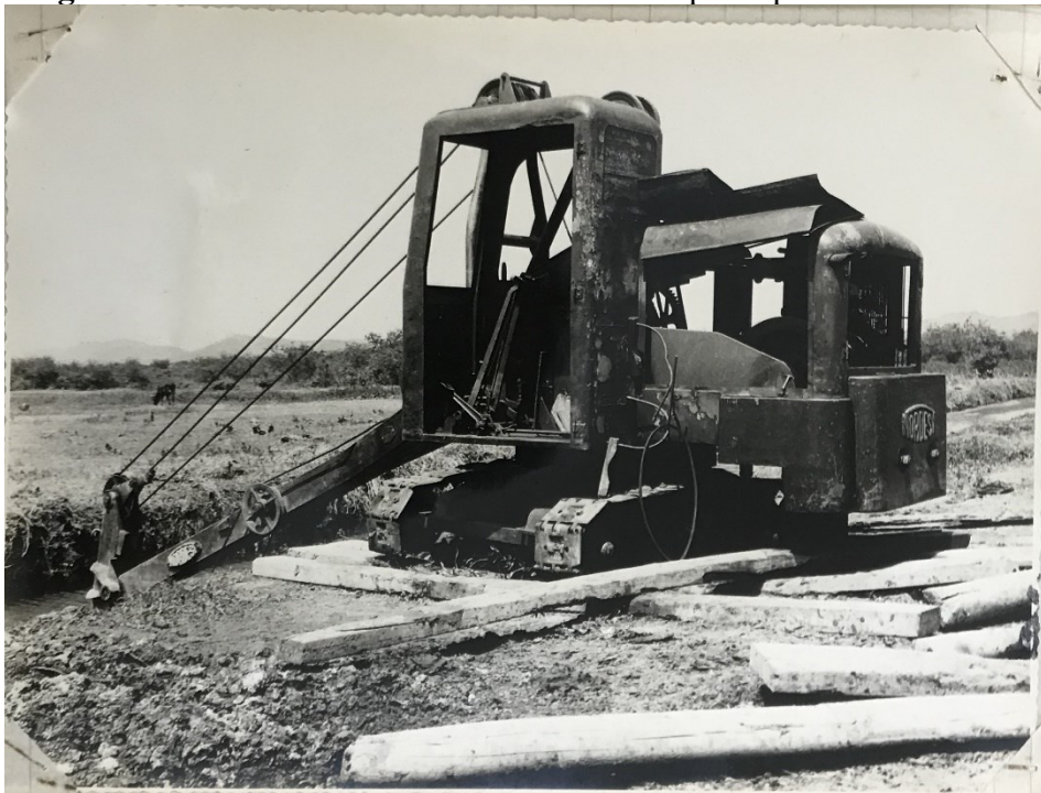
Figura 15: Guindaste colocado dentro da vala pelos posseiros da FAC.
