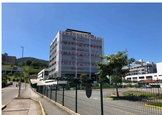
Figura 1. Complexo Techno Towers, onde está localizada a empresa Nanoscopying.
