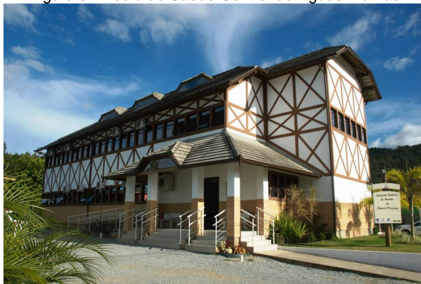
Figura 3 - Posto de Saúde Central de Águas Mornas
