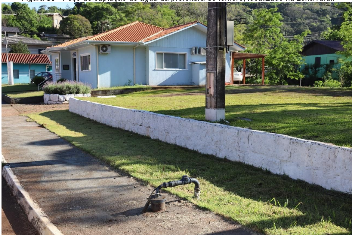
Figura 86 - Poço de captação de água da prefeitura de Iomerê, localizado na zona rural.
