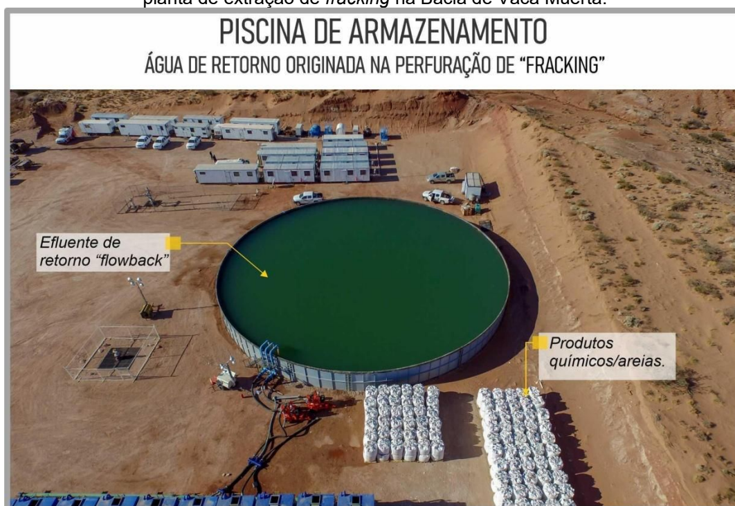
Figura 40 - Efluente de retorno e armazenamento de produtos químicos a serem utilizados em uma planta de extração de fracking na Bacia de Vaca Muerta.
