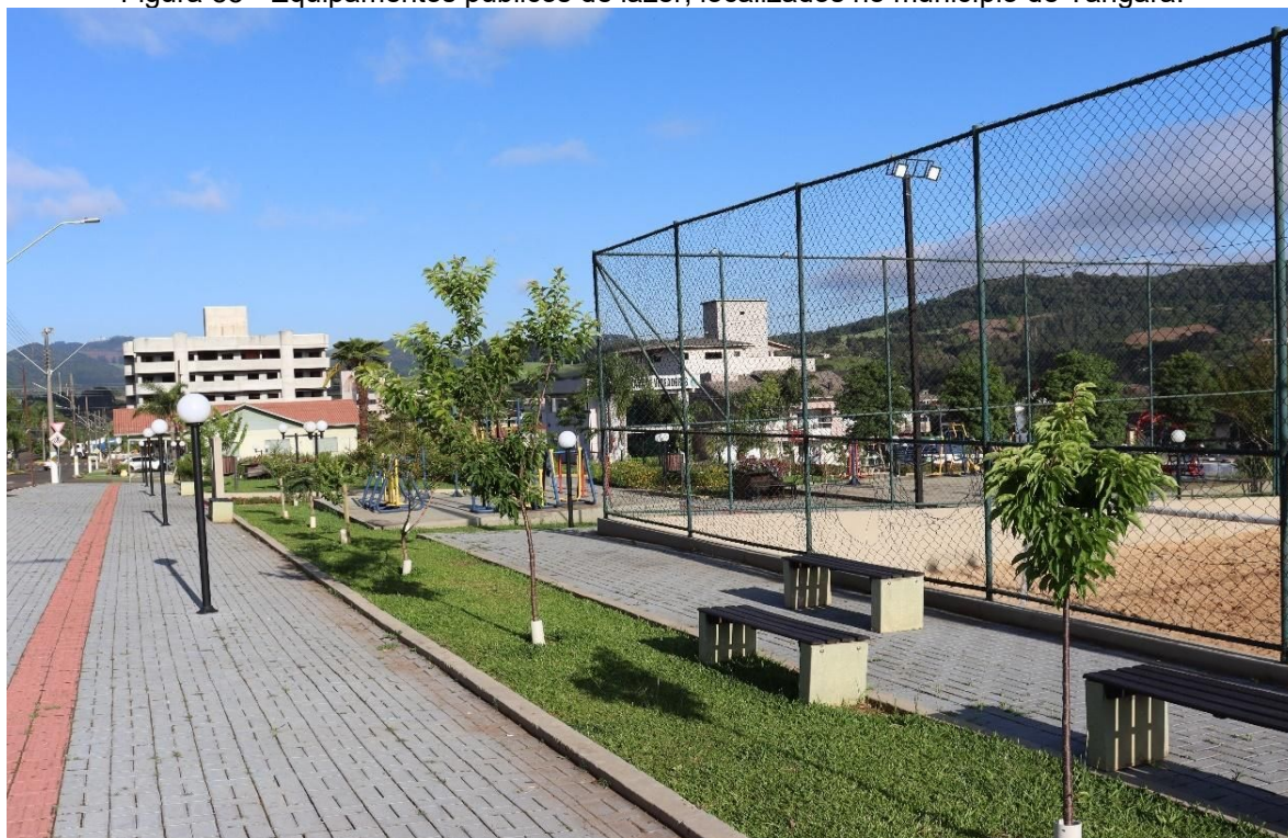
Figura 88 - Equipamentos públicos de lazer, localizados no município de Tangará.
