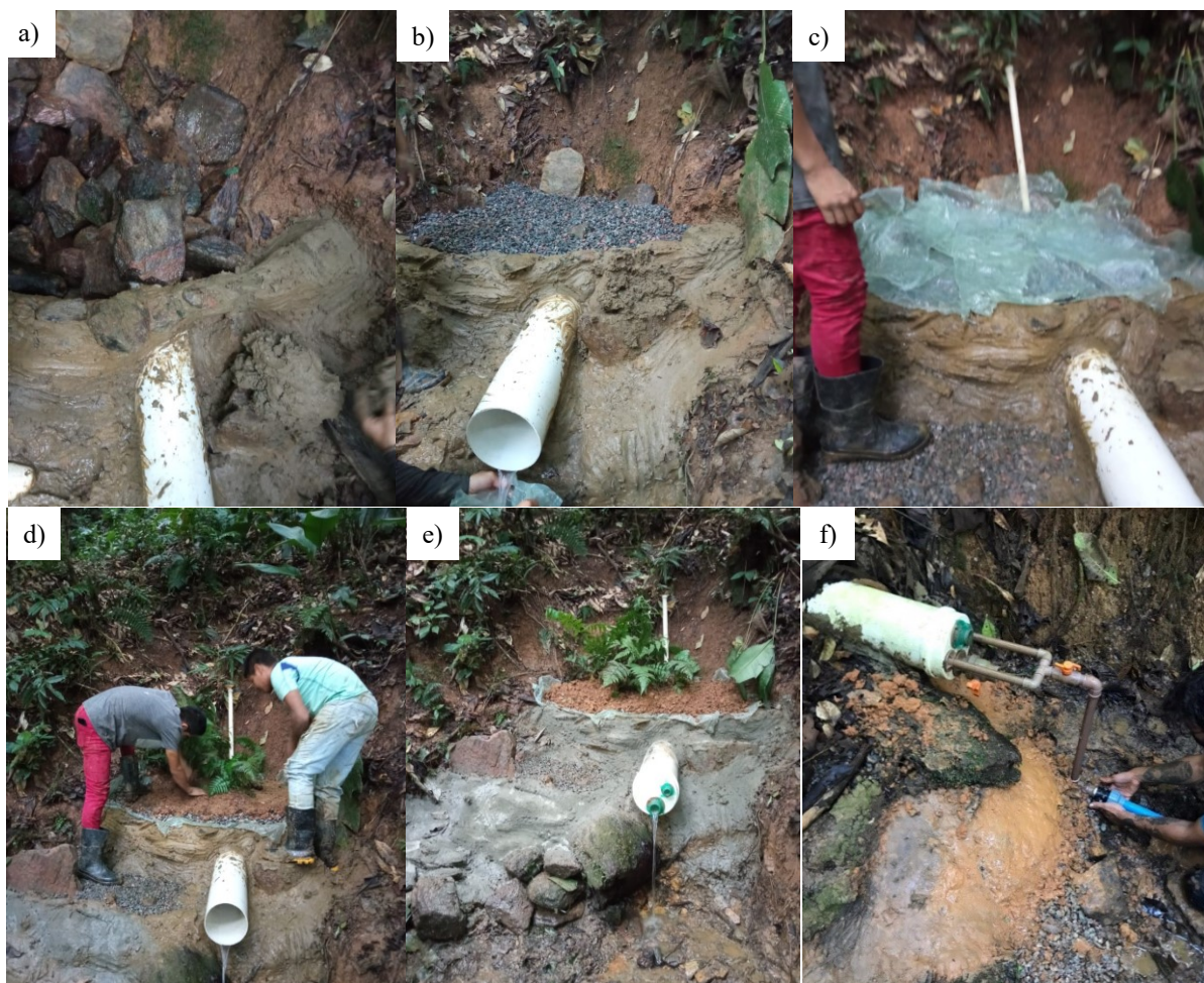
Figura 20 – Evolução da construção da Proteção de Nascentes Caxambu na Nascente 1 Fonte: Acervo NEAmb (2023)
