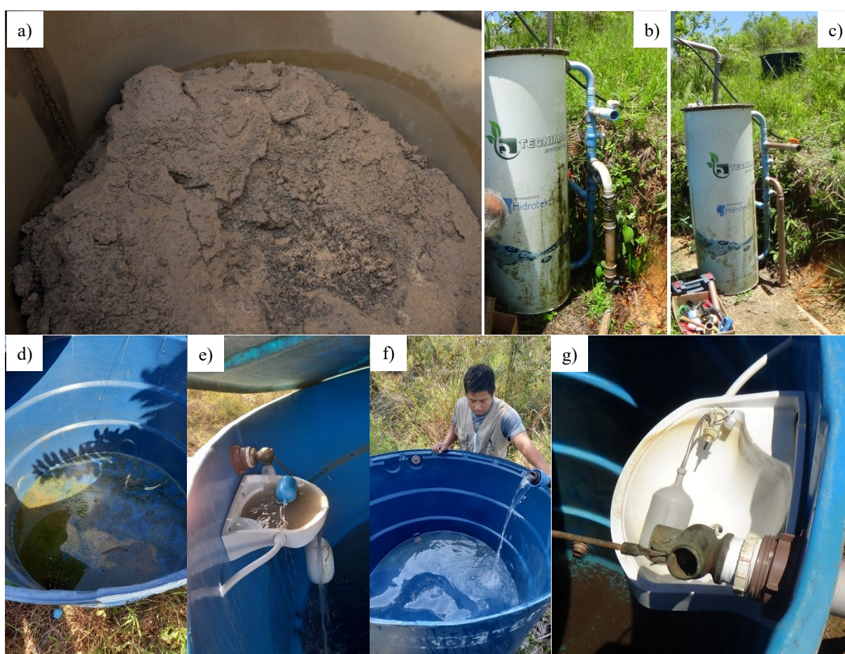
Figura 25 – Imagens das manutenções no Filtro Rápido e Clorador Fonte: Acervo NEAmb (2023)
