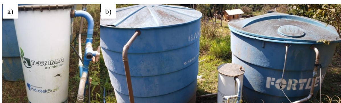
Figura 23 – Filtro de pressão (a) reservatórios (b) da Tekoa Vy'a Fonte: Adaptado de Quillfeldt (2021) e Pabis (2022)
