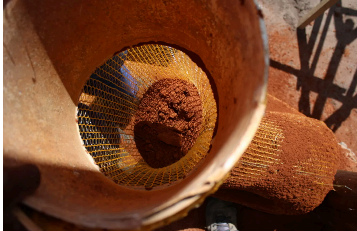
Figura 16 - Hiperadobe em construção. Fonte: Bioconstrução Brasil (2024).
