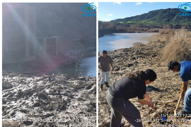
Figura 48: Extração dos materiais próximo a barragem norte. Fonte: galeria do autor (2023).
