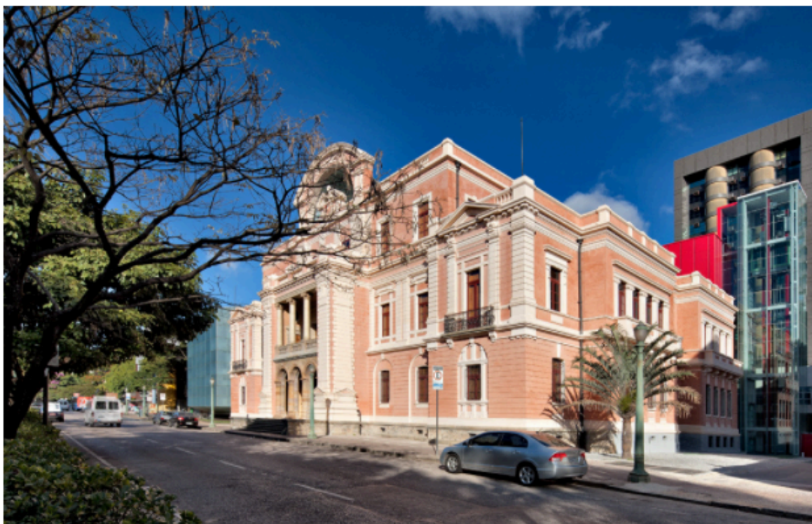
Figura 7: Fachada do Prédio Rosa
