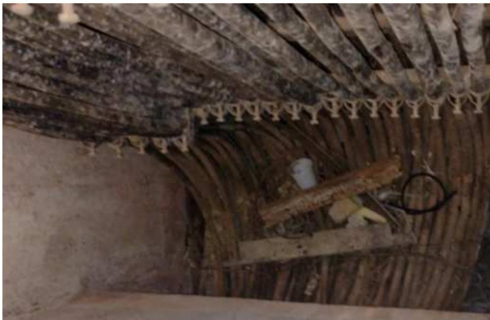
Figura 5 – Chegada dos cabos de controle das linhas de 500 kV no piso inferior do edifício de controle da SEA.
