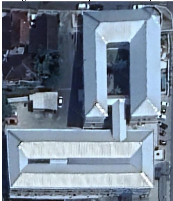
Figura 10 – Vista superior da edificação.
