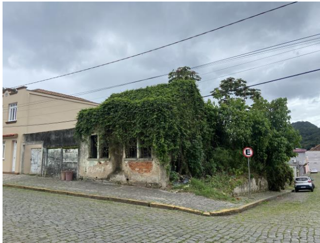
FOTO: Fachada frontal, vista da esquina.
