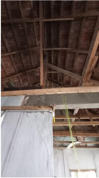
FOTO: Vista interna da cobertura.
