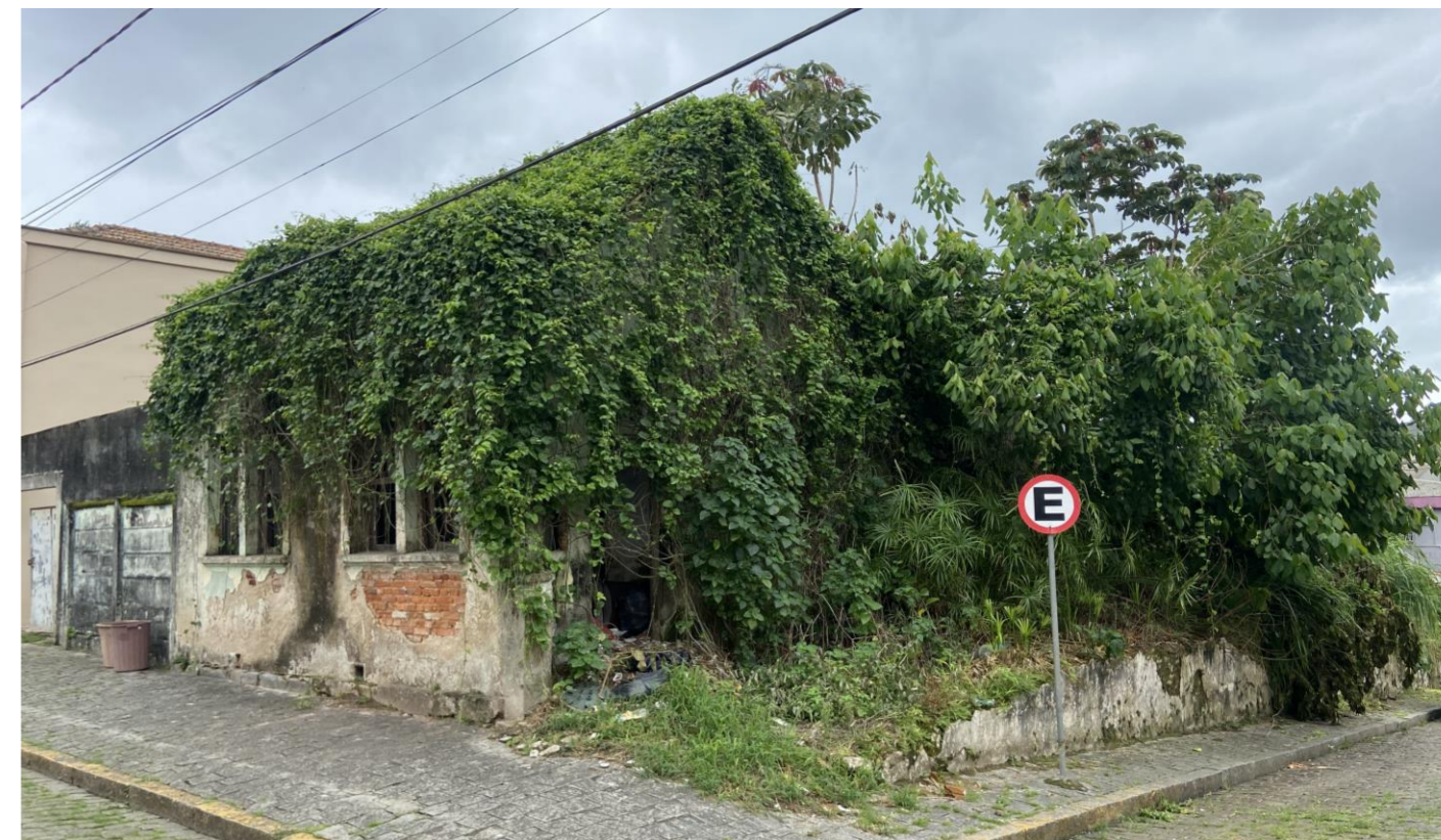
Figura 26: Fachada vista da esquina, coberta com a vegetação. Fonte: Autora (2024)
