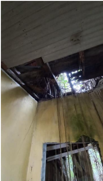
FOTO: vista do forro e cobertura.
