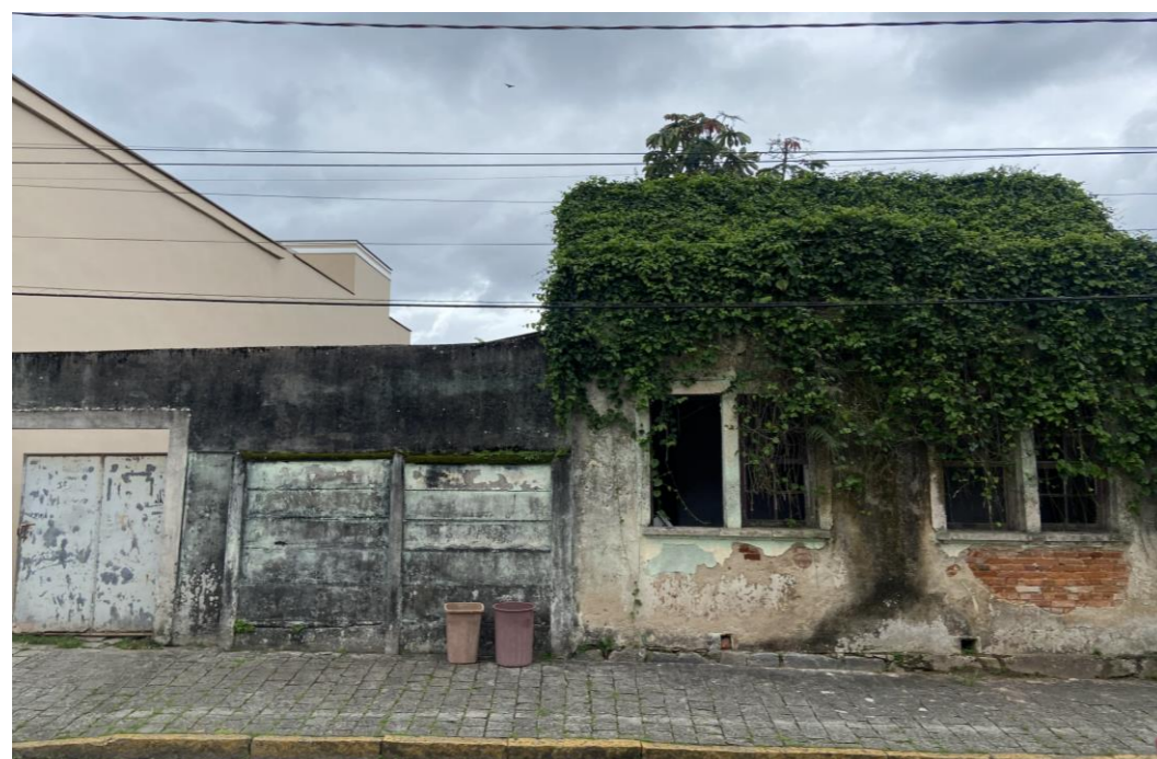
Figura 27: Fachada rua Fernando Machado. Fonte: Autora (2024)
