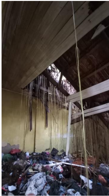
FOTO: vista da cobertura e interior.
