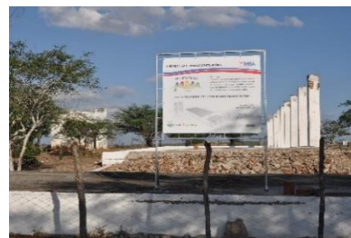
Assentamento Vitória: Sistema coletivo de captação e armazenamento de água de chuva, com capacidade de 260 mil litros de água. Reforma realizada pela comunidade e participação efetiva de todos os parceiros.
