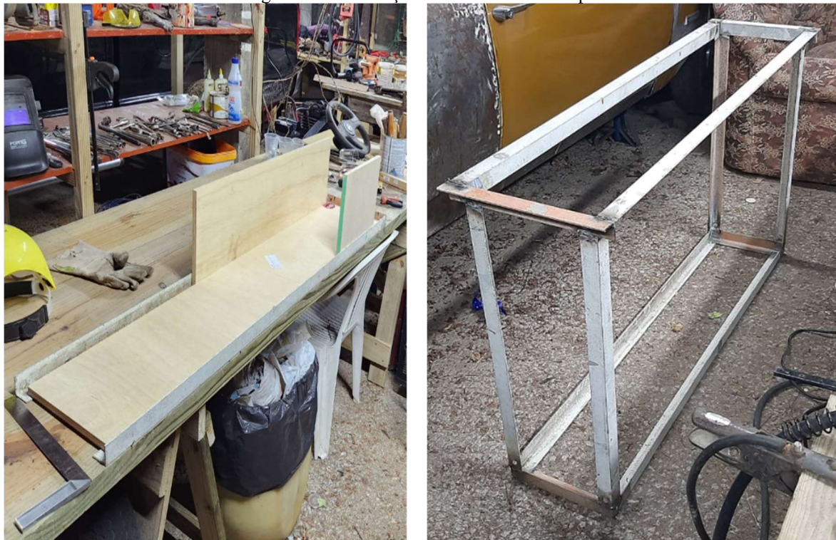
Figura 48 - Fabricação da estrutura do tanque.
