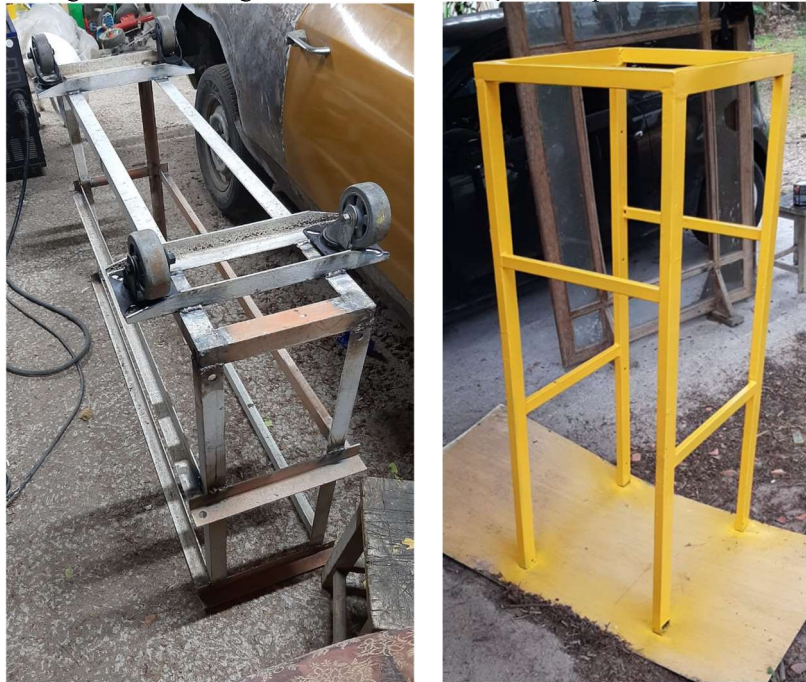
Figura 49 - Montagem das rodas e fabricação do suporte do cilindro.
