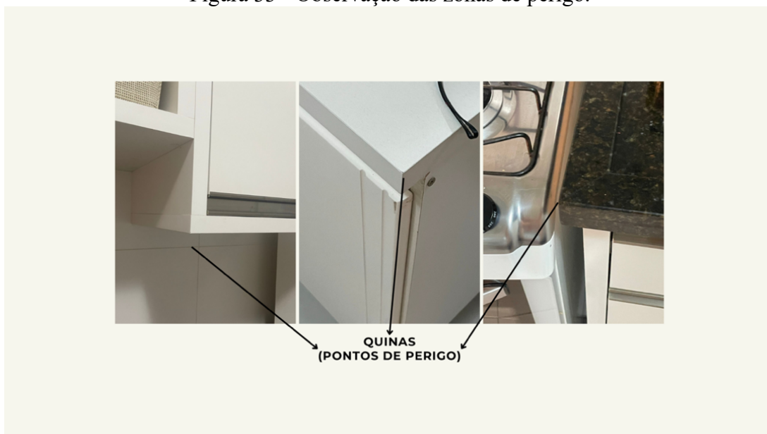
Figura 33 - Observação das zonas de perigo.
