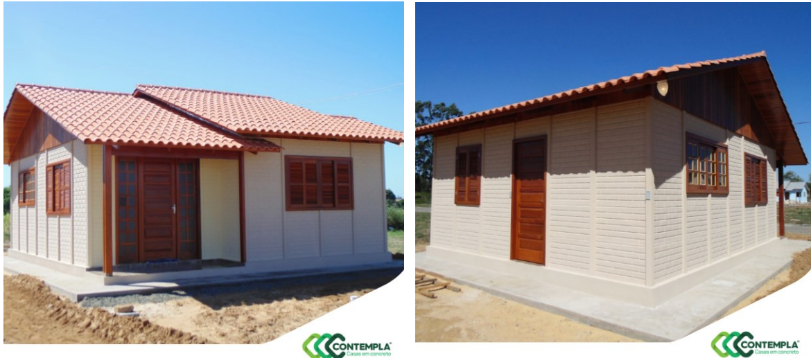
Figura 9 – Perspectivas do projeto em Paredes de Concreto
