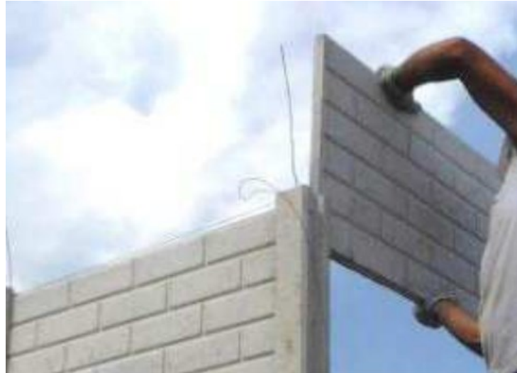
Figura 7 – Montagem de painel de vedação para a construção de uma parede.
