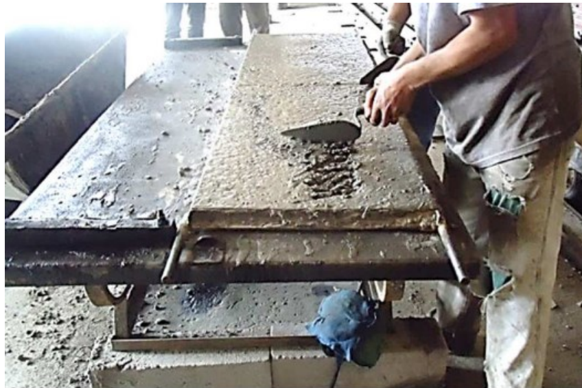
Figura 6 – Pré-fabricação de um painel de vedação que formará parte de uma parede
