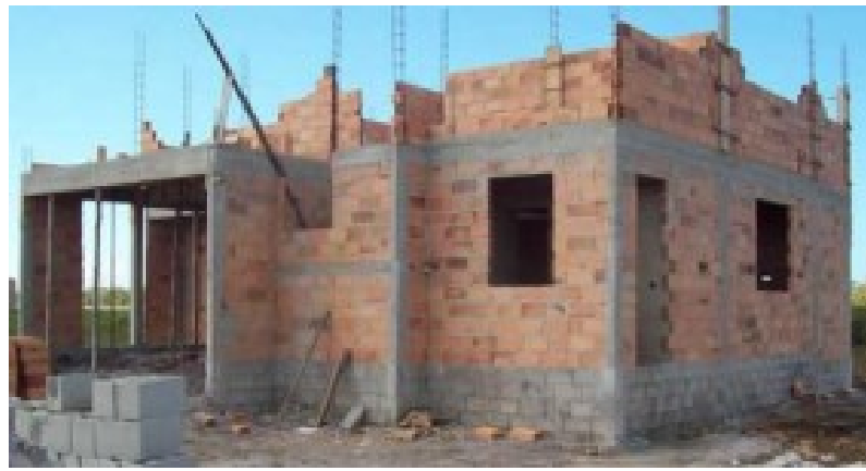
Figura 11 – Habitação em Alvenaria Convencional em fase de construção
