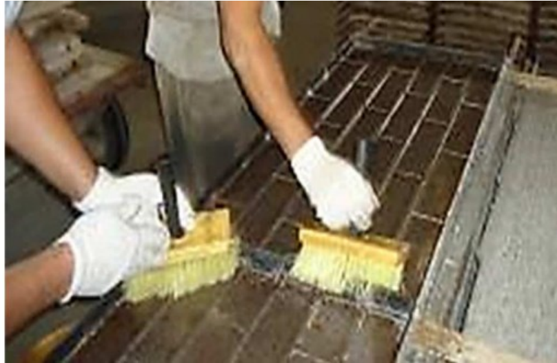
Figura 5 – Pré-fabricação de um painel de vedação que formará parte de uma parede
