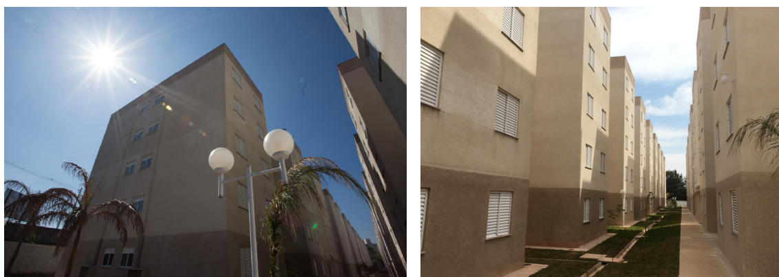
Figuras 9 e 10: Conjunto Residencial Vila Espanha. Fonte: HZR Construtora e a autora.
