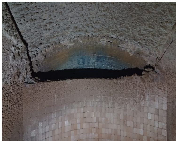
Figura 15 – Parede refratária superior FTB.
