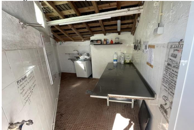
Figura 8. Zona de Preparação de Alimentos, CERAS.
