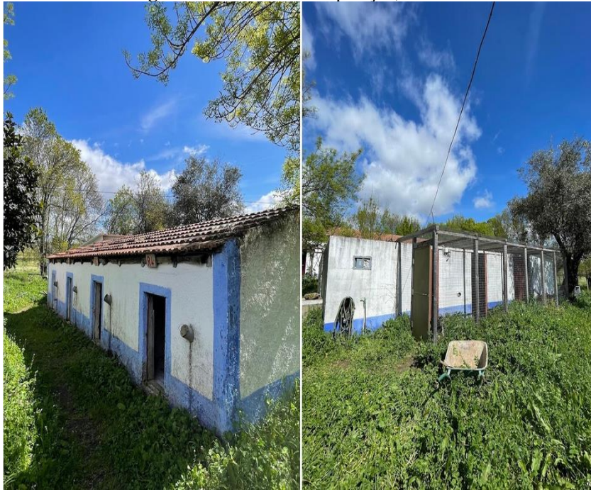
Figura 3. Câmaras de recuperação, CERAS.
