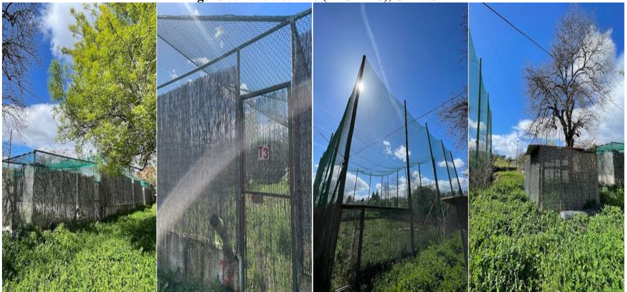
Figura 5. Túneis de Voo (T1-5 + TC), CERAS.
