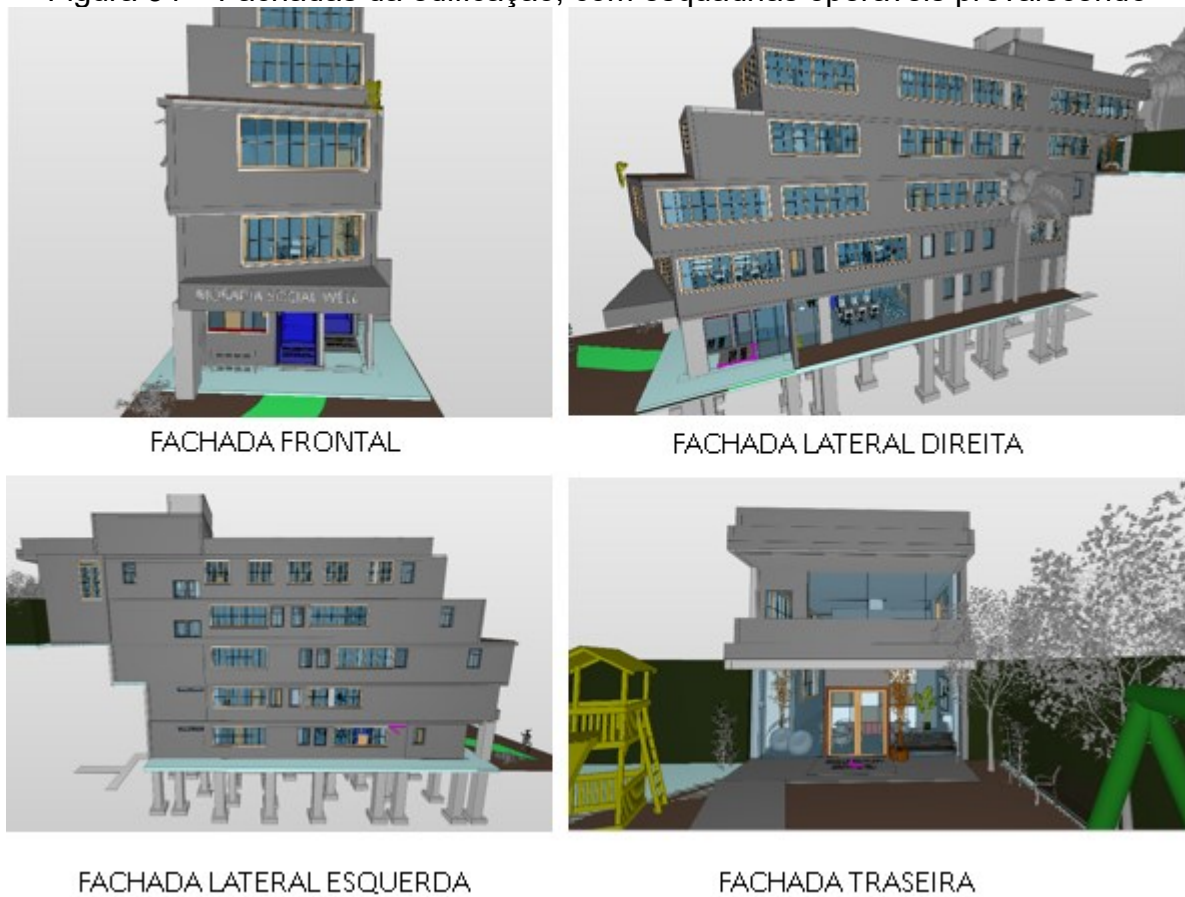
Figura 34 – Fachadas da edificação, com esquadrias operáveis prevalecendo
