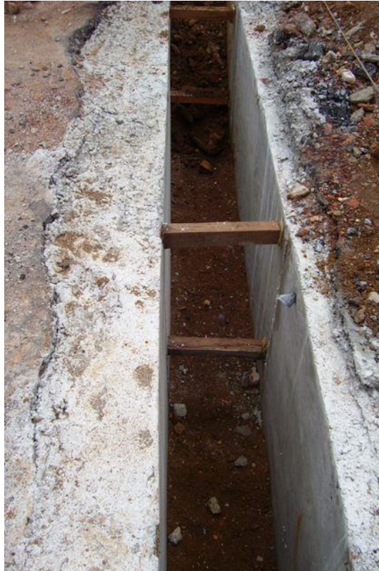
Figura 2.2 – Mureta guia concretada para parede diafragma de 40 cm de espessura
