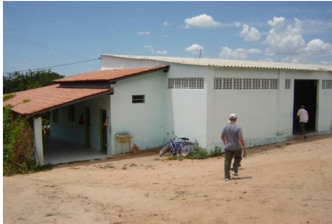
Figura 7. Construção de apoio ao cultivo de peixes em tanques-rede da Associação de Jovens Criadores de Peixes (AJCP).
