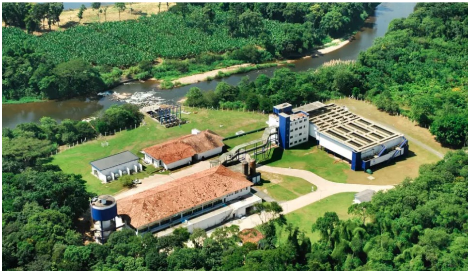
Figura 3 - Estação de Tratamento de Água Cubatão (ETA Cubatão).
