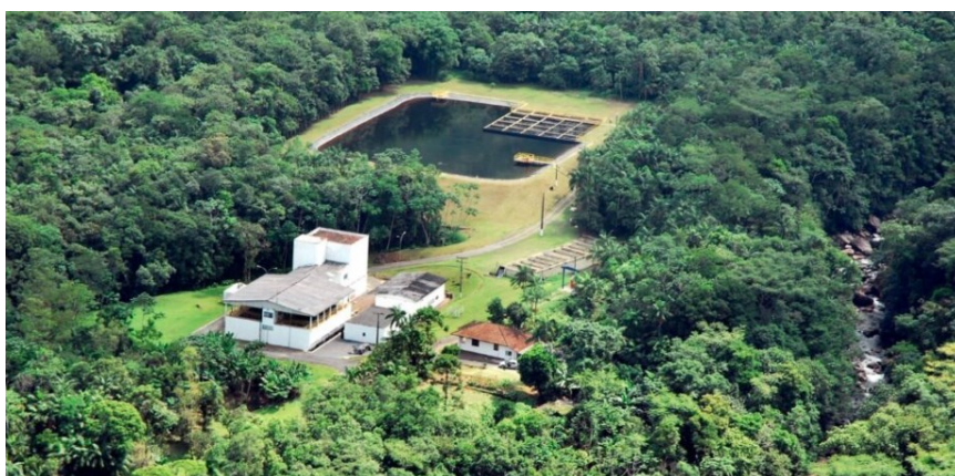
Figura 4 - Estação de Tratamento de Água Pirai (ETA Pirai).
