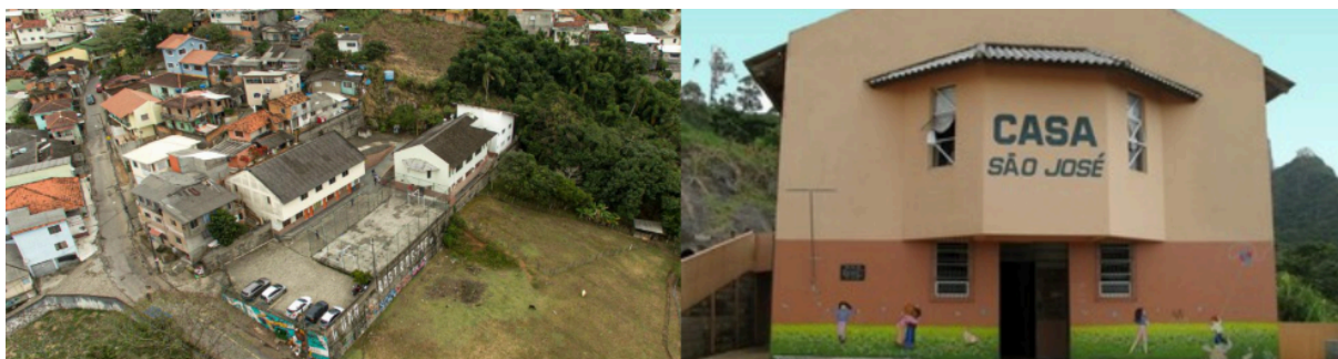
Figura 4 – Local da “Casa São José”.
