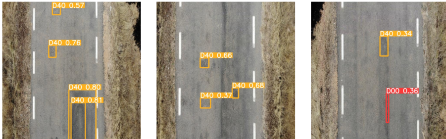
Figura 3 – Detecção de defeitos em rodovias utilizando YOLOv8
