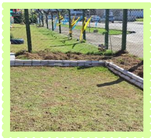
Figura 8: Leira de compostagem, preparando o canteiro para a horta
