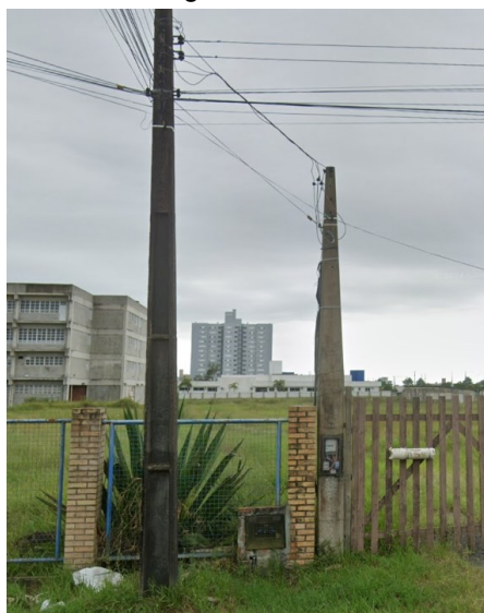
Figura 31 - Entrada de energia - ARA - Entrada Provisória CTS03.
