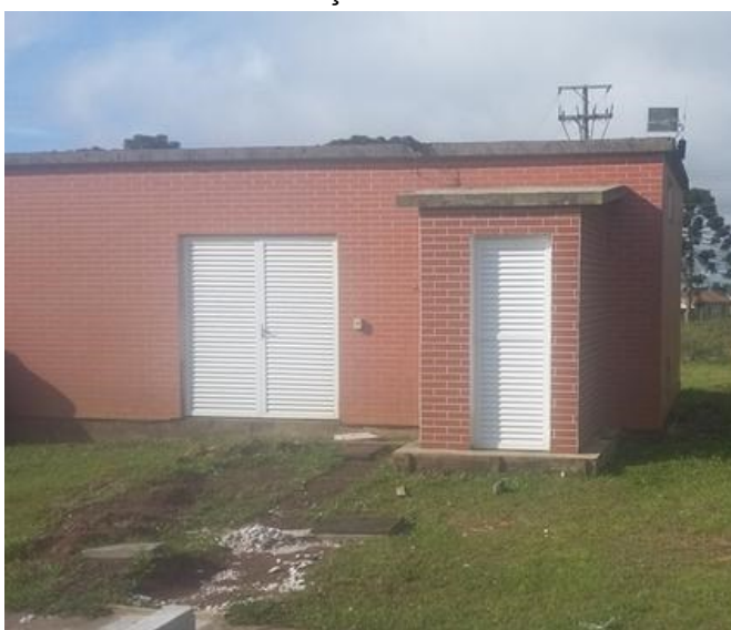
b. Subestação SE200-CBS
