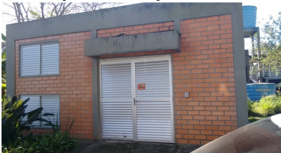
Figura 16 - Entrada de energia - FLN.ITA - CCA.
