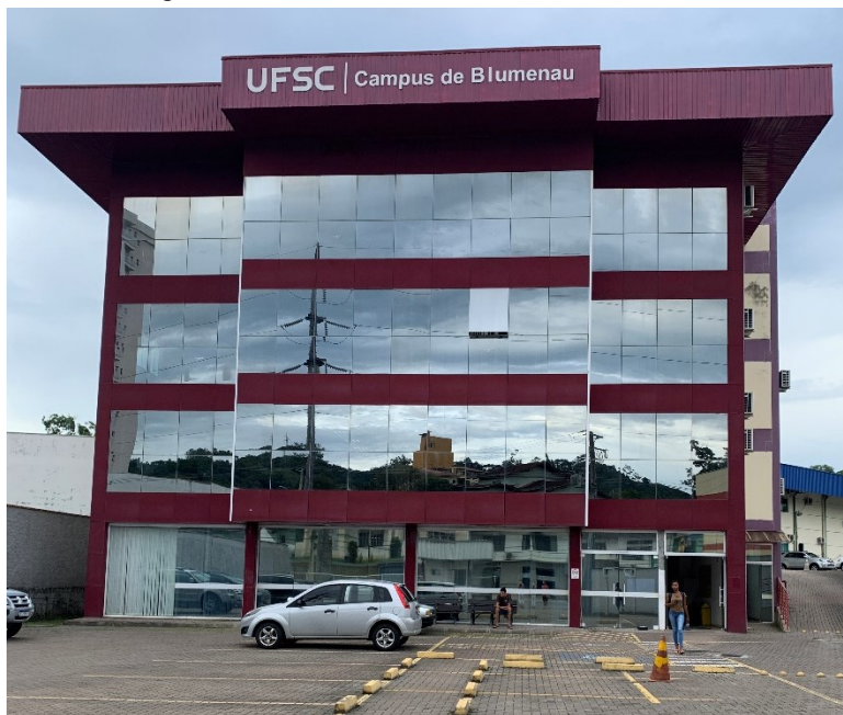
Figura 33 - Edifício - BNU - Sede Acadêmica.
