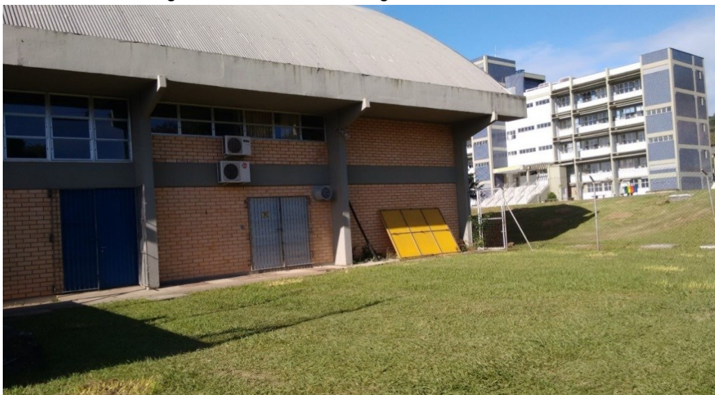
Figura 15 - Entrada de energia - FLN.TRI - CMD04.
