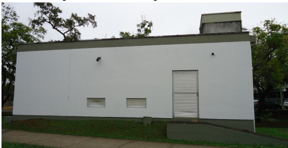
Figura 12 - Entrada de energia - FLN.TRI - CMD01.
