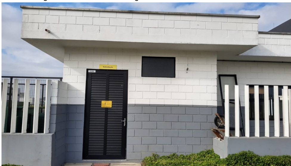
Figura 19 - Entrada de energia - JVL.PER - Bloco Universitário.
