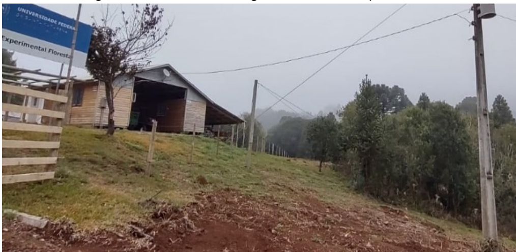
Figura 28 - Entrada de energia - CBS - Área Exp. Florestal.
