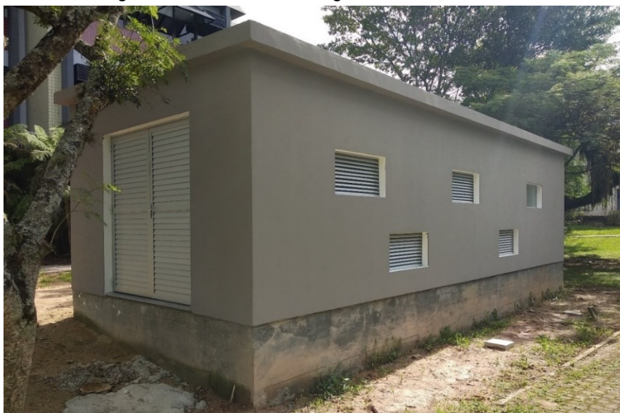
Figura 14 - Entrada de energia - FLN.TRI - CMD03.
