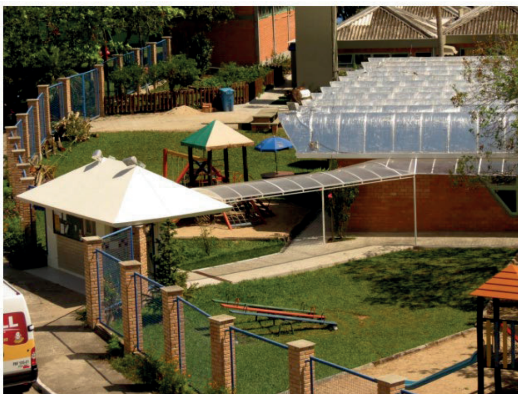
Figura 12 – Cercamento utilizado no NDI e Campus de Araranguá
