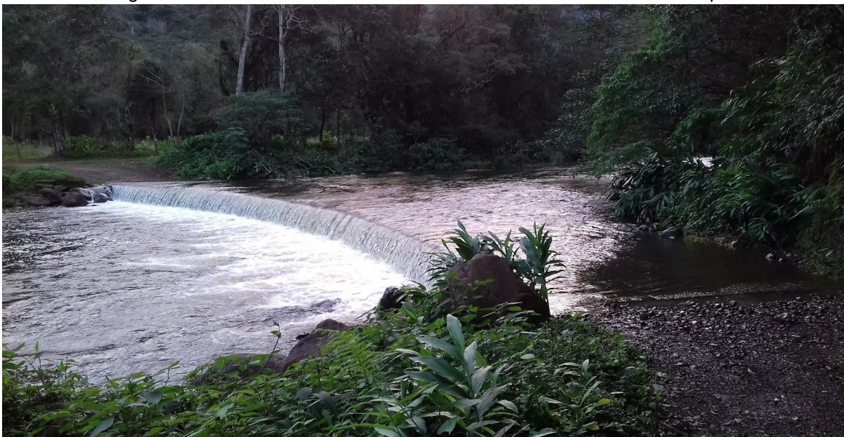
Figura 2 – Ponte molhada sobre o rio faxinalzinho no Quilombo São Roque.
