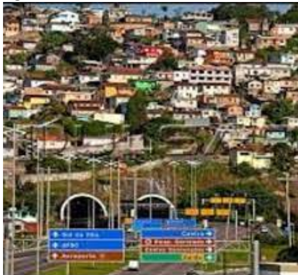
Figura 1: Túnel Antonieta de Barros e do Morro do Mocotó
